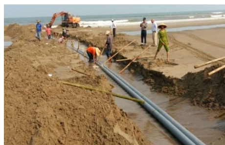
Hình 11: Lắp đặt ống hút
