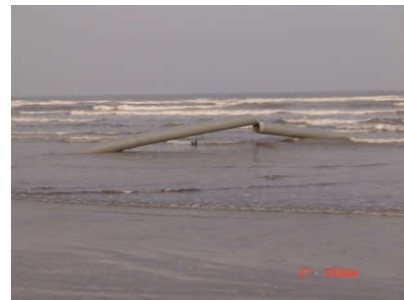
Hình 8: Đường ống hút bị phá hủy
