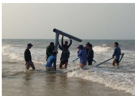
Hình 9: Thu nước qua tầng cát lọc theo phương thẳng đứng
